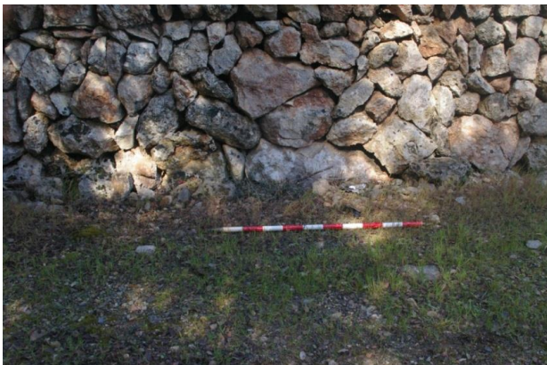
Vista de blocs inserits en un marge.
