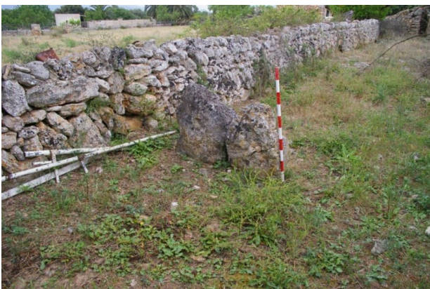
Vista dels blocs possible estructura J.033.2
