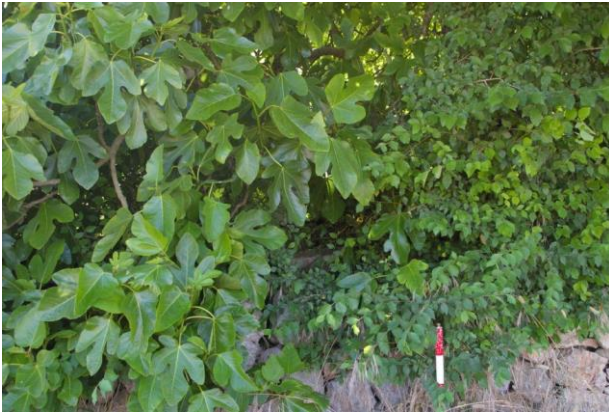
Vista de l'estructura J.047.14.Pou de ses Piques.
