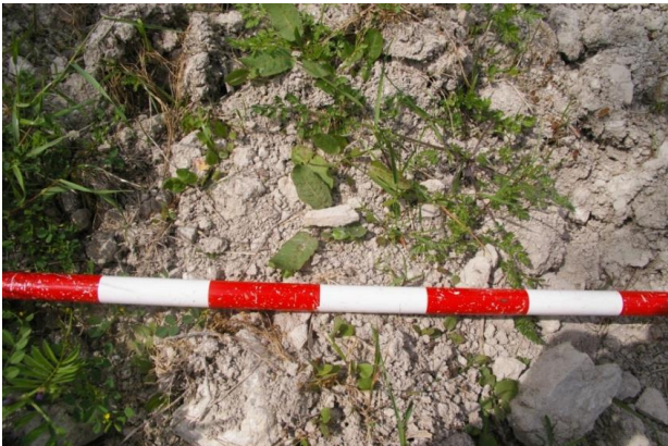
Vista detall material que s'observa les tanques 7,97,147.
