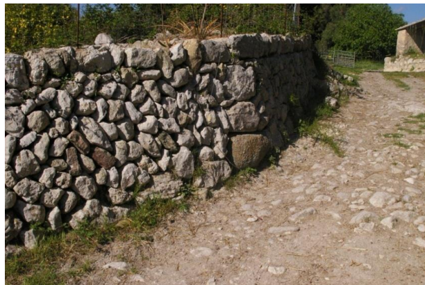
Blocs inserits a un marge.
