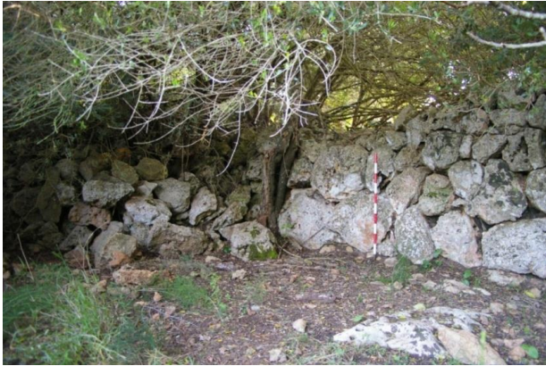
Vista Estructura J.008.2, mur adossat talaiot
