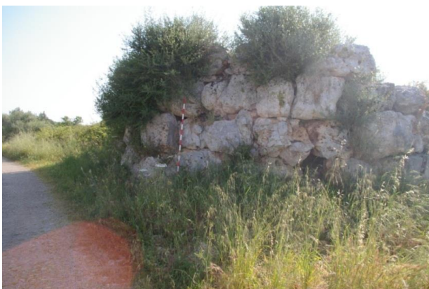
Vista de l'estructura J.006.2
