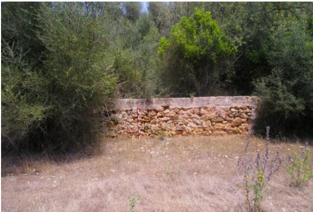
Vista de l'estructura J.047.15. Interior de s'Hort de Son Rossinyol.
