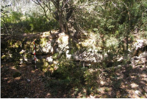
Vista del que seria l'interior de la cova que s'ha enderrocat.
