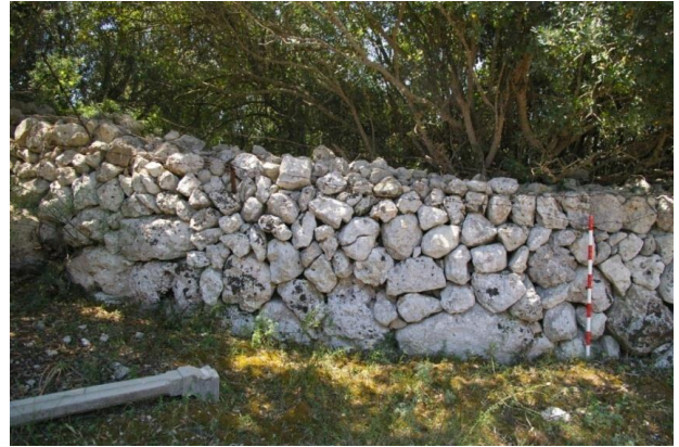
Vista Marge amb blocs reaprofitats.
