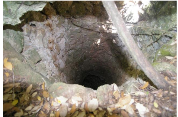
Vista de l'estructura J.047.2. Pou d'aireig.
