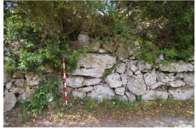
Vista detall del mur ciclopi
