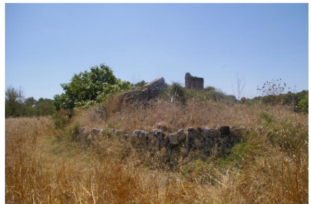
Vista de l'estructura J.047.5. Vista general de la sínia
