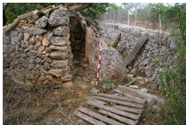
Vista de cabana amb blocs reaprofitats. Parcel·la 86.
