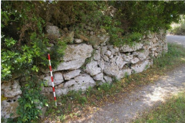
Vista detall del mur ciclopi
