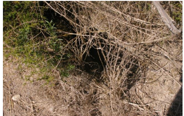
Vista de l'estructura J.047.11. Pou d'aireig.
