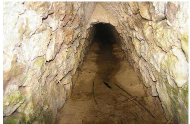
Vista de l'estructura J.047.13 Vista de la entrada a la síquia coberta.
