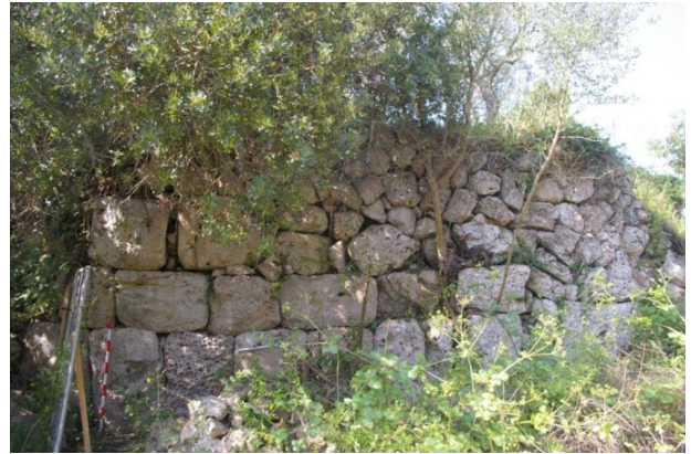
Estructura J.006.8. de planta quadrada
