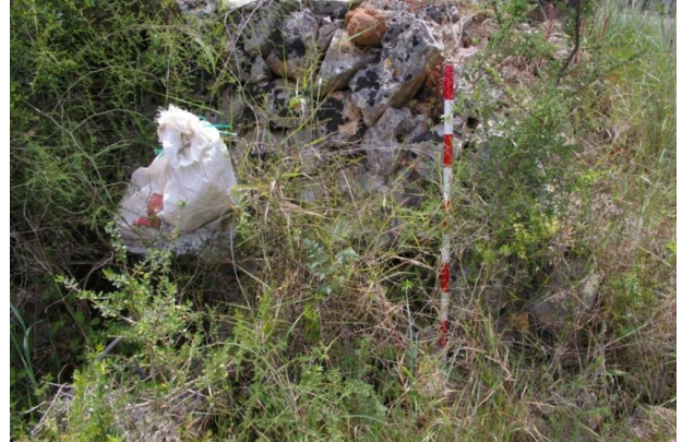
Claper amb blocs de mitjanes i grans dimensions a la part inferior.
