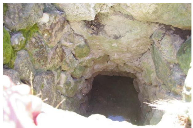
Vista de l'estructura J.047.7. Pou d'aireig.
