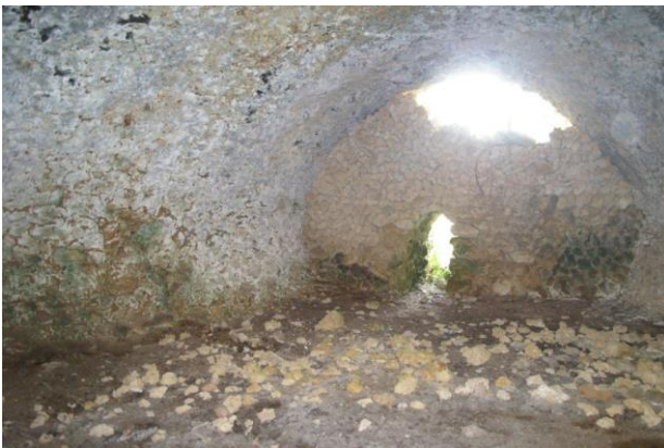
Vista de la façana des de l'interior.
