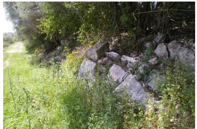
Vista de la pedrera.
