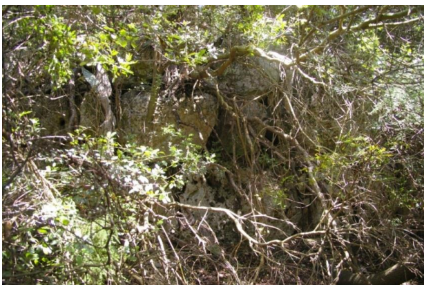
Vista de l'estructura J.006.6
