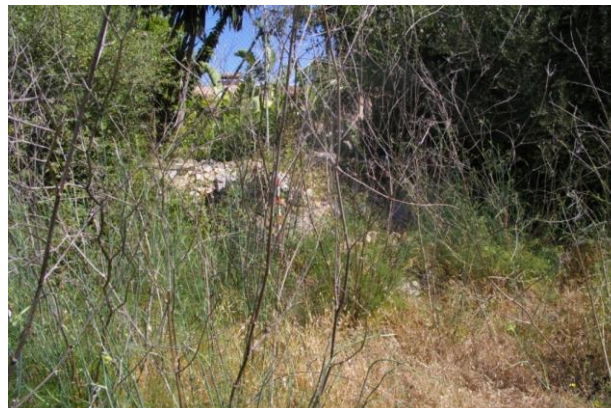
Marge amb blocs reaprofitats.
