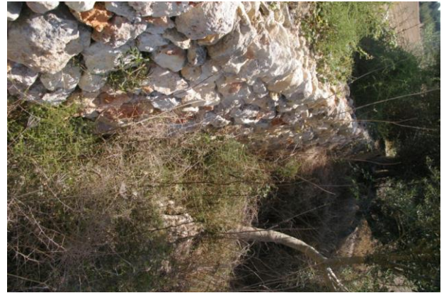
Vista de l'estructura J.047.9 Vista general de la síquia.
