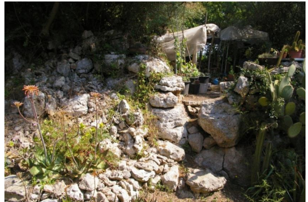
Vista de l'estructura J.006.9
