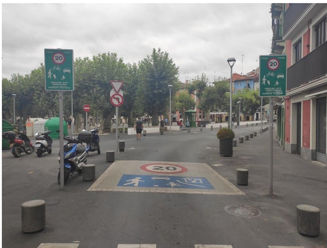
Fig. 48. Portes d'entrada a zona 30 i zona 20
